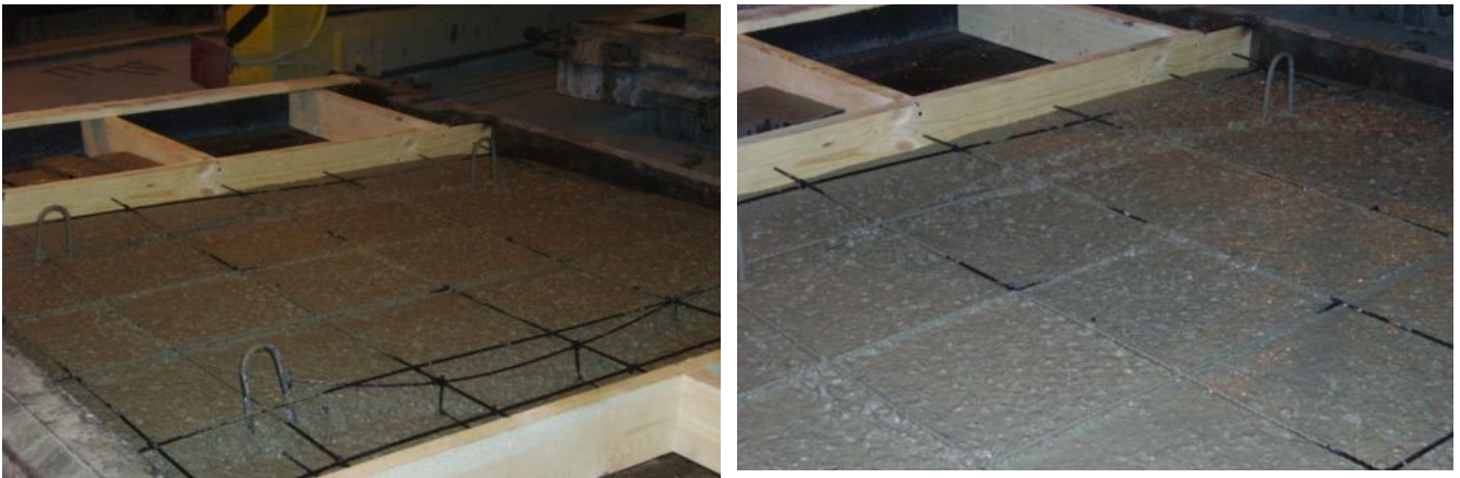
Рисунок 7.2 – Общий вид опалубочных форм с бетонной смесью на этапе изготовления дорожных плит с АНК-Б
