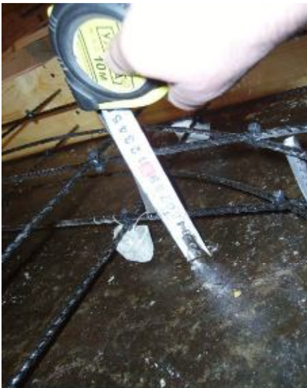
Рисунок 7.4 – Фрагменты арматурных каркасов из базальтопластиковых стержней, уложенных в опалубочную форму дорожной плиты с контролем их геометрических параметров
