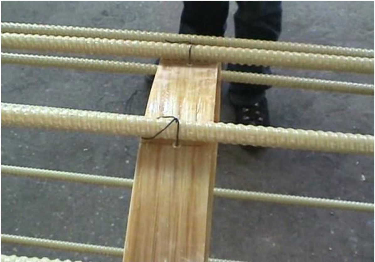
Рисунок 9.32 – Деталь крепления рабочего стержня АНК-С к кольцу жесткости
