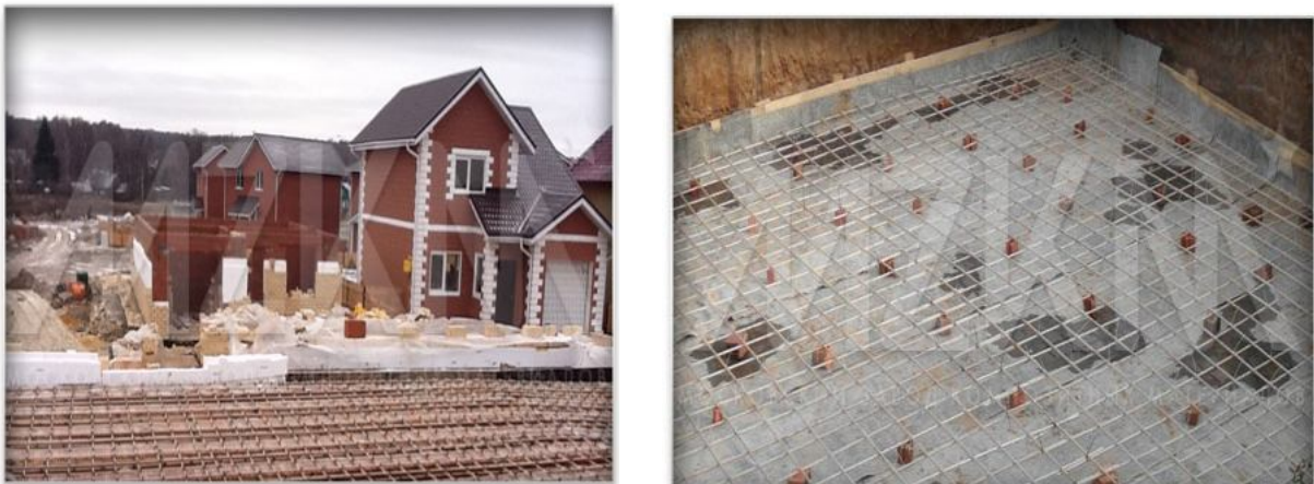
Рисунок 9.3 – Применение АНК для армирования фундаментной плиты
