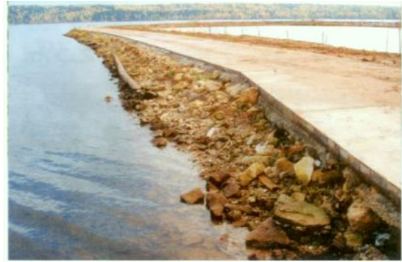
Рисунок 9.24 – Сооружение буны с использованием композитной арматуры
