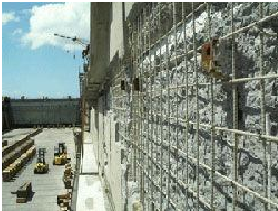
Рисунок 9.11 – Сетка из АНК под покрытие стены крепления котлована
