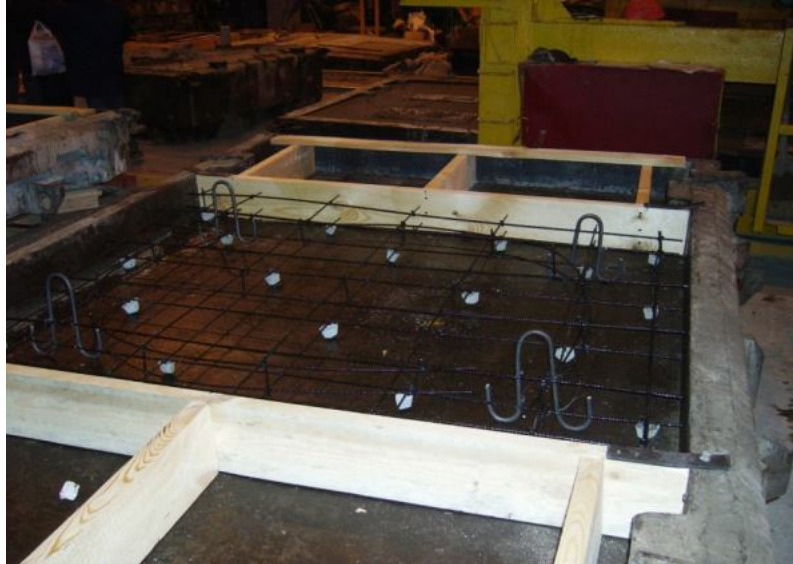
Рисунок 7.3 – Общий вид арматурных каркасов (сеток), уложенных в опалубочную форму опытного образца дорожной плиты
