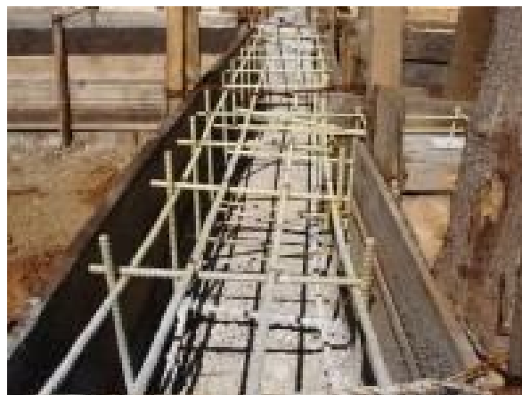
Рисунок 9.6 – Армирование фундамента по периметру сооружения
