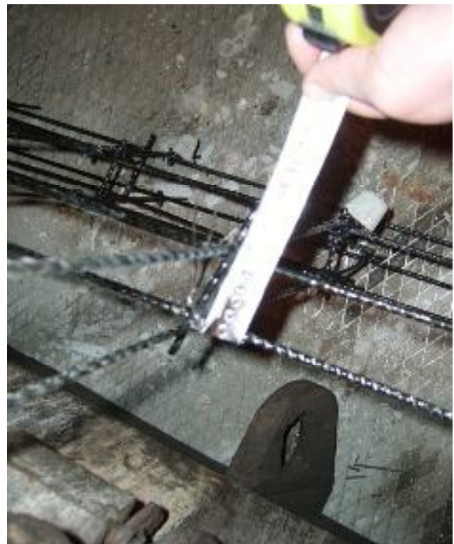
Рисунок 7.4 – Фрагменты арматурных каркасов из базальтопластиковых стержней, уложенных в опалубочную форму дорожной плиты с контролем их геометрических параметров
