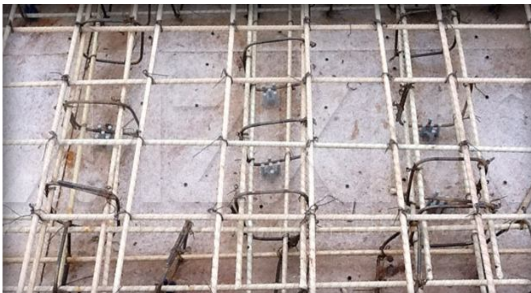
Рисунок 5.2 – Объемный каркас из АНК
