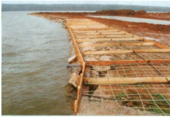
Рисунок 9.24 – Сооружение буны с использованием композитной арматуры
